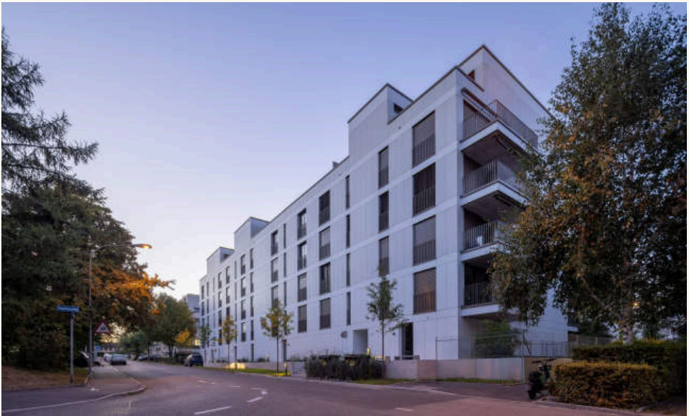
Abendansicht von der Unterfeldstrasse: Haus 40 im Vordergrund, Haus 44 dahinter; die Faserzementfassade im Plattenraster, die Balkone als Teil der Hülle, über dem Eingang die zurückgesetzte Attika. Foto: foter.sk
