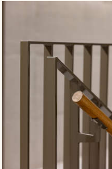
18 Treppenhaus: Sichtbeton, Lichtlinie unter der Decke, Stabgeländer in dunklem Olivton. 19 Geländerdetail: Flachstäbe, Handlauf aus Eiche. Foto: foter.sk
