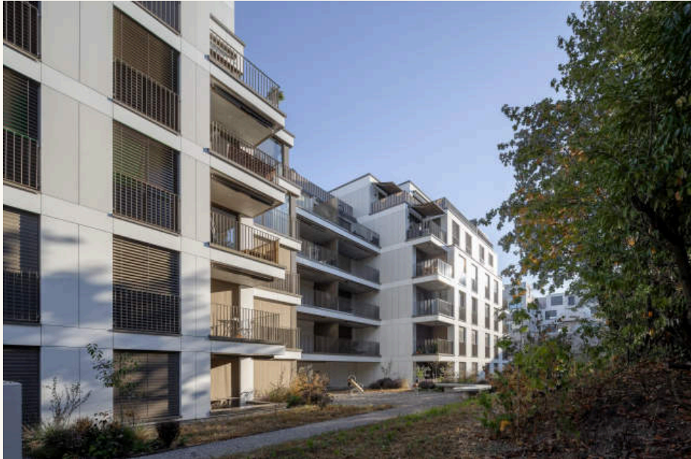
5 Hofseite zwischen den Baukörpern: Balkonzone mit verputzten Untersichten, Zip-Stores als Sonnenschutz, Metallteile im dunklen Olivton. Foto: foter.sk
