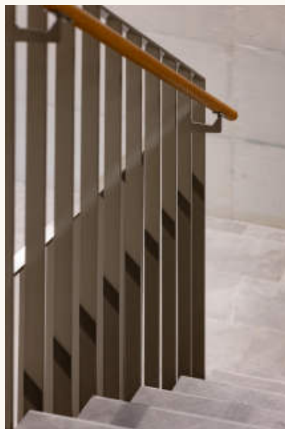
3 Treppenhaus in Sichtbeton: Stufen in Feinsteinzeug, Wandleuchten, Geländer aus Flachstahl mit Handlauf in Eiche. 4 Geländerdetail: pulverbeschichtete Flachstahlstaketen, der Handlauf auf Konsolen abgesetzt. Foto: foter.sk
