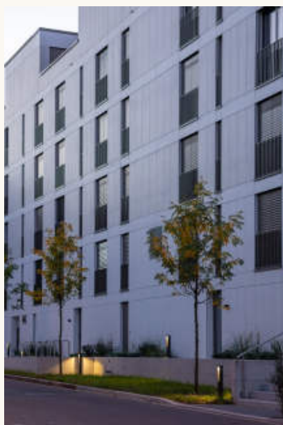
12 Haus 44 von der Unterfeldstrasse am Abend: die Lochfassade im Plattenraster, französische Balkone, Polerleuchten im Vorgarten. 13 Die zurückgesetzte Attika hinter den Bäumen: Faserzementplatten, Stabgeländer, Rafflamellenstoren. Foto: foter.sk
