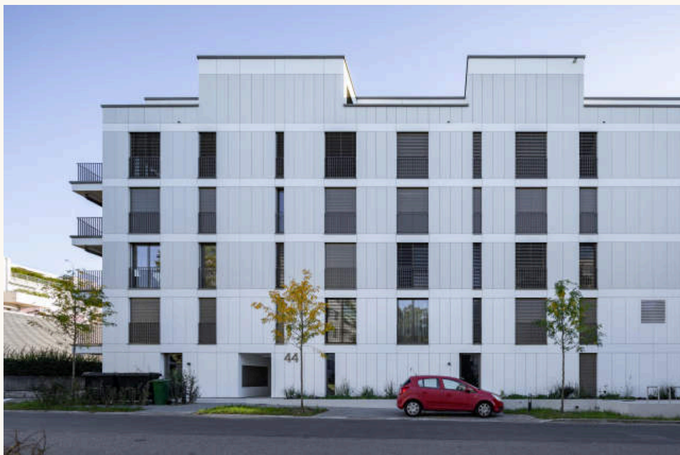
2 Strassenfassade Haus 44: Lochfassade im Plattenraster, Rafflamellenstoren und französische Balkone; im Erdgeschoss der Hauseingang als Einschnitt. Foto: foter.sk
