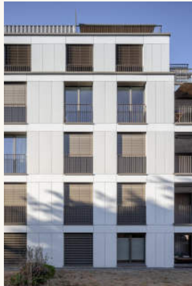
6 Gebäudeecke zum Hof: vorgelagerte Balkone mit Staketengeländern, Senkrechtmarkisen und Rafflamellenstoren, davor die Sitzbank in Beton. 7 Das Fassadenraster frontal: grossformatige Faserzementplatten, geschosshohe Öffnungen mit französischen Balkonen, alle sichtbaren Metallteile im dunklen Olivton. Foto: foter.sk
