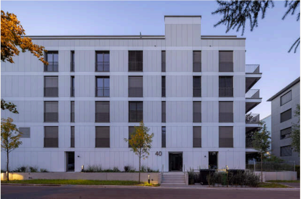
8 Haus 40 von der Strasse: Lochfassade im Raster der Faserzementplatten, zurückgesetztes Attikageschoss, der Eingang als Einschnitt mit Treppe und Rampe. Foto: foter.sk
