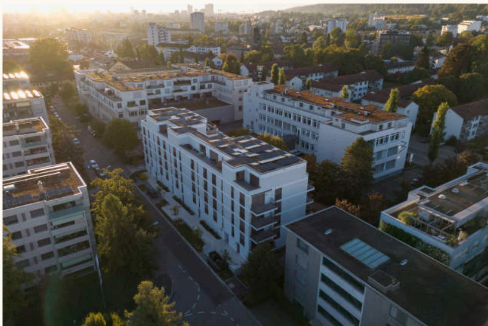
20 Blick gegen Westen: Haus 40 an der Unterfeldstrasse, die Balkone zur Hofseite, die Attikageschosse mit Sonnenstoren; im Hintergrund die Stadt. Foto: foter.sk
