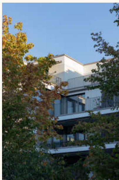
12 Haus 44 von der Unterfeldstrasse am Abend: die Lochfassade im Plattenraster, französische Balkone, Polerleuchten im Vorgarten. 13 Die zurückgesetzte Attika hinter den Bäumen: Faserzementplatten, Stabgeländer, Rafflamellenstoren. Foto: foter.sk
