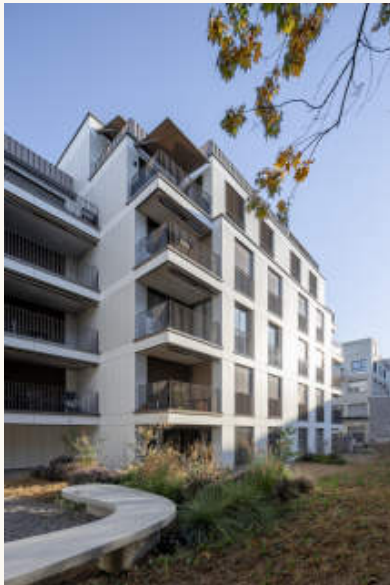
6 Gebäudeecke zum Hof: vorgelagerte Balkone mit Staketengeländern, Senkrechtmarkisen und Rafflamellenstoren, davor die Sitzbank in Beton. 7 Das Fassadenraster frontal: grossformatige Faserzementplatten, geschosshohe Öffnungen mit französischen Balkonen, alle sichtbaren Metallteile im dunklen Olivton. Foto: foter.sk
