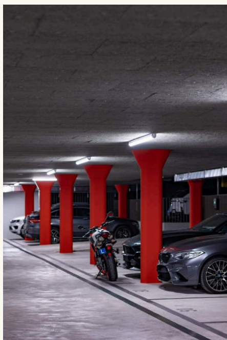
23 Die roten Pilzstützen der Einstellhalle – der Bestand, auf dem die beiden Häuser stehen. Foto: foter.sk
