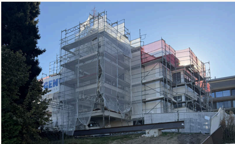
1 Baustelle im Oktober 2026: der Rohbau am Hang eingerüstet, das Steildach im Aufbau; davor die Böschung zur Baumschutzzone am Rand der Parzelle. Foto: Ivanov + Partners
