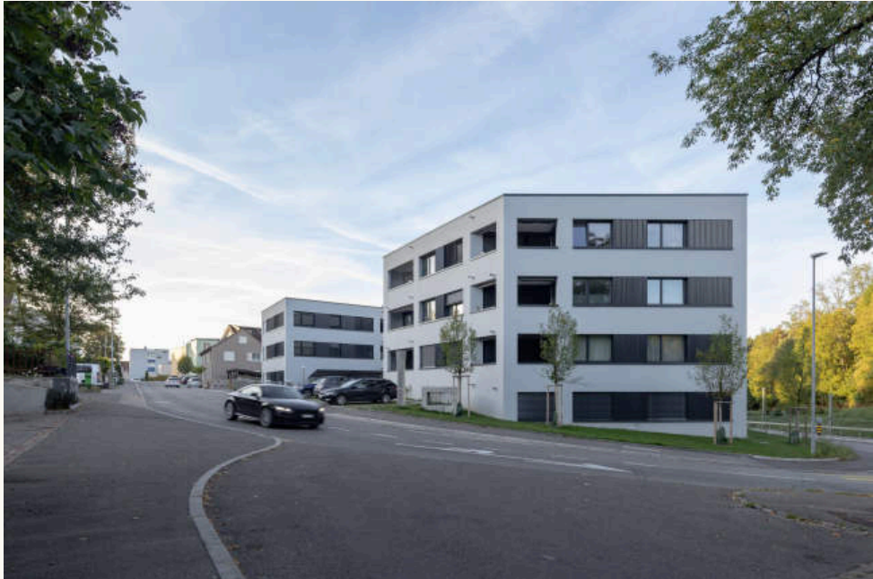
2 Die Anlage von der Engestrasse her gesehen: Die Baukörper folgen dem Strassenverlauf, die Loggien sind in die verputzte Fassade eingeschnitten, dazwischen liegen Fensterbänder mit dunklen Metallpaneelen. Foto: foter.sk
