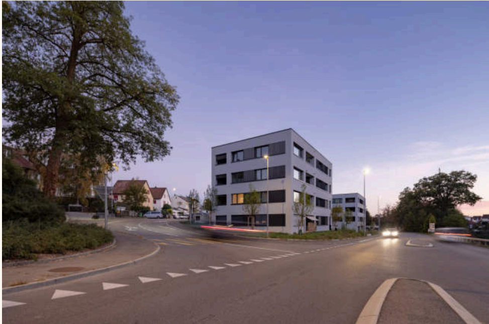
12 Die Anlage am Abend von der Strassenkreuzung: Die hellen Putzfassaden stehen ruhig im Strassenraum, die dunklen Paneele und Stoffbänder zeichnen die Geschosse nach. Foto: foter.sk
