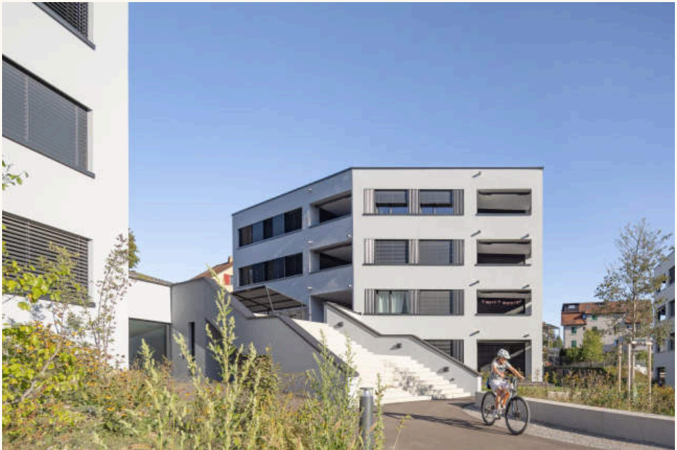
11 Wohnhof zwischen den Häusern: Freitreppe, Staudenbepflanzung und Wegeführung bilden den gemeinsamen Freiraum; die Loggien sitzen als Einschnitte in der Fassade. Foto: foter.sk
