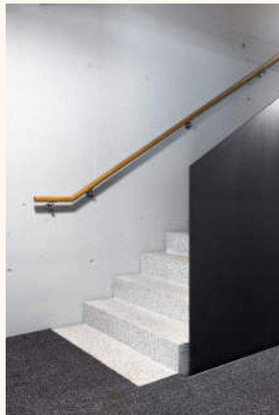
3 Treppenhaus: Sichtbetonwände, Treppenstufen in Terrazzo, Geländer aus schwarzem Stahlblech und Handlauf in Eiche. 4 Treppenlauf im Detail: Der Eichenhandlauf ist auf Edelstahlkonsolen an die Sichtbetonwand gesetzt. Foto: foter.sk
