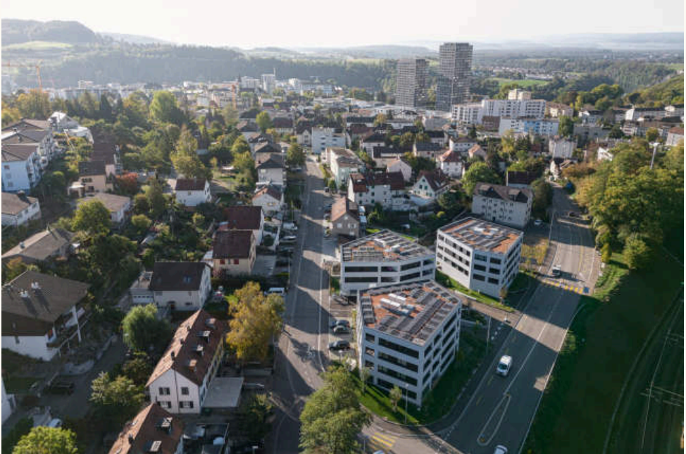
14 Von oben: Auf den Dächern liegen Extensivbegrünung und Photovoltaik, die Baukörper fügen sich in den Massstab der Einfamilienhaus-Nachbarschaft. Foto: foter.sk
