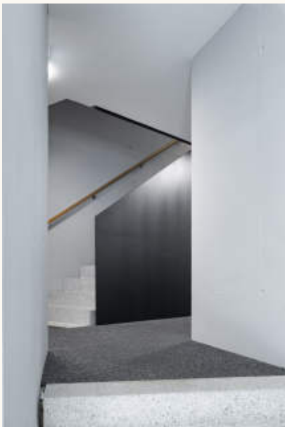
6 Podest im Treppenhaus: Sichtbeton, schwarze Stahlbrüstung und Teppichbelag in einer reduzierten Palette.
