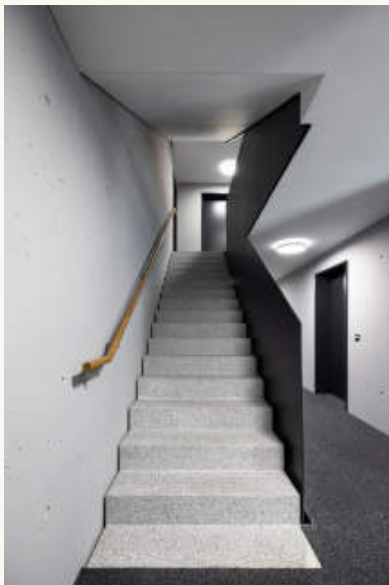
3 Treppenhaus: Sichtbetonwände, Treppenstufen in Terrazzo, Geländer aus schwarzem Stahlblech und Handlauf in Eiche. 4 Treppenlauf im Detail: Der Eichenhandlauf ist auf Edelstahlkonsolen an die Sichtbetonwand gesetzt. Foto: foter.sk
