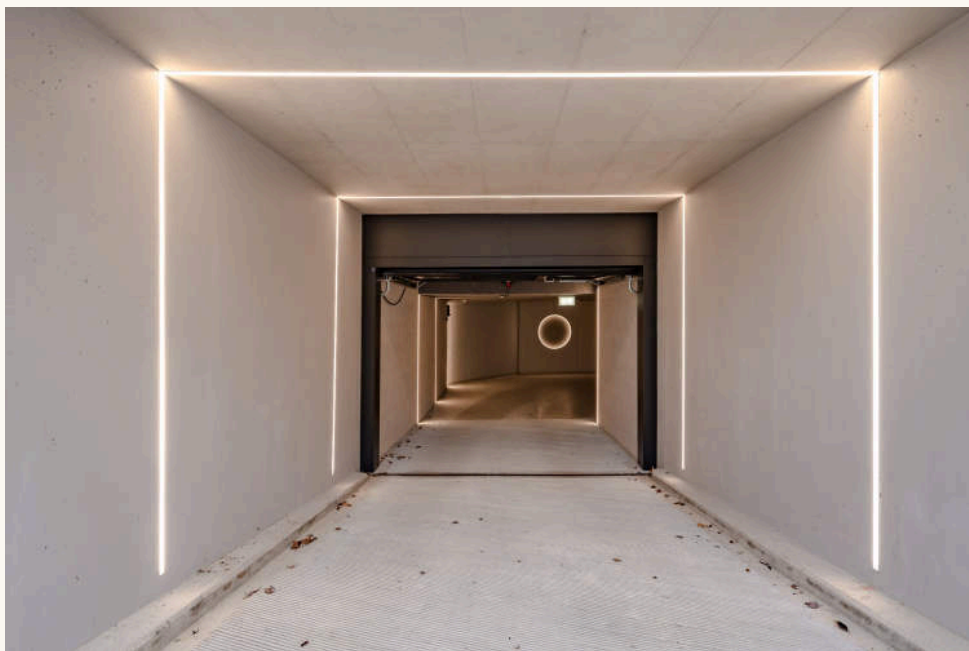
15 Einfahrt zur Tiefgarage: Lichtlinien zeichnen die Kanten des Sichtbetonraums nach; das Tor als dunkler Rahmen, dahinter die Ringleuchte der Garage. Foto: foter.sk
