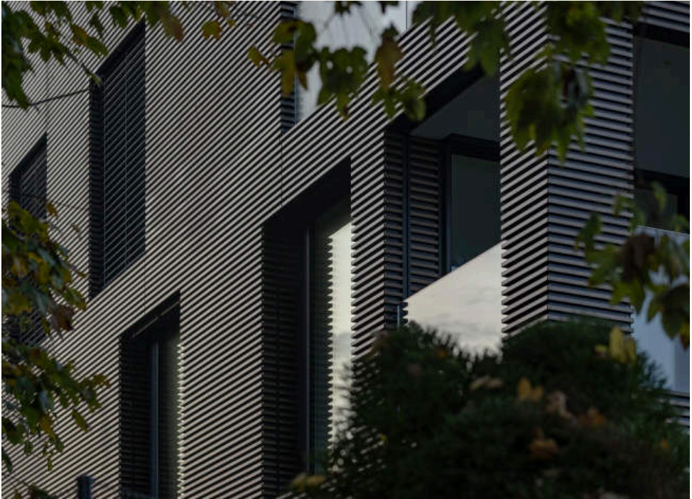
3 Fassadendetail: Die Profile sind auf ein schwarz beschichtetes Grundblech geklipst; das Eloxal ergibt keinen Farbton, sondern einen Verlauf nach Licht und Sonnenstand. Foto: foter.sk
