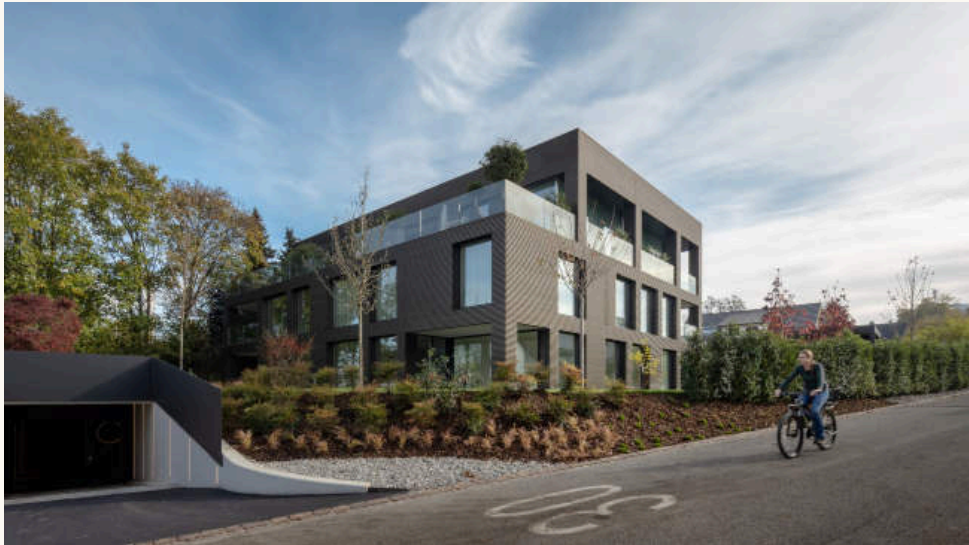
1 Ansicht von Nordwesten. Die hinterlüftete Fassade aus horizontalen, eloxierten Aluminiumprofilen läuft ohne Dachrandabschluss über Dachkante, Brüstung und Fläche hinweg; links die Einfahrt zur Tiefgarage.
