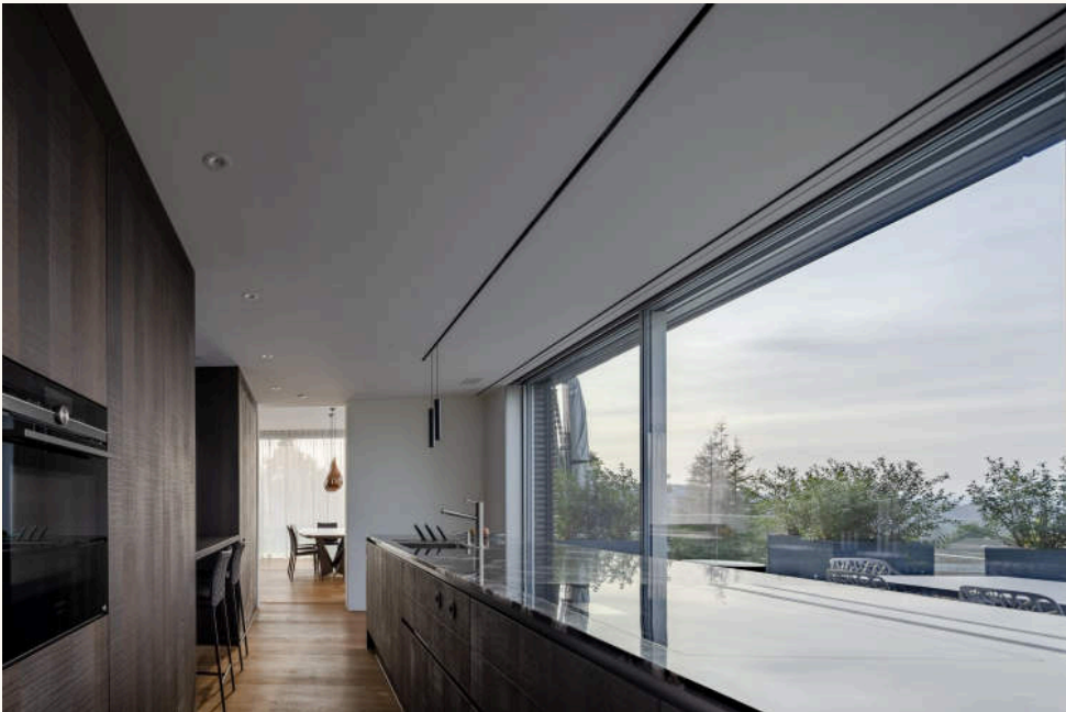
13 Küche im Penthouse: das rahmenlose Schiebefenster über die ganze Länge der Arbeitsfläche, die Brüstung aus Glas, dahinter Terrasse und Dachgarten. Foto: foter.sk
