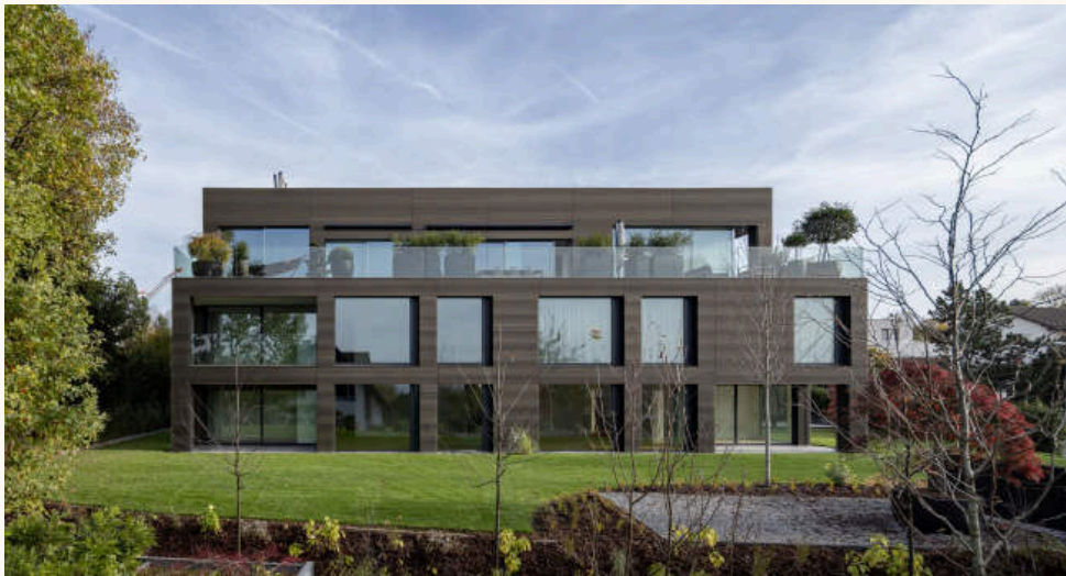
2 Gartenseite: geschosshohe Öffnungen in der Lochfassade, davor Loggien und Terrassen; das Penthouse tritt hinter der Glasbrüstung des Dachgartens zurück. Foto: foter.sk
