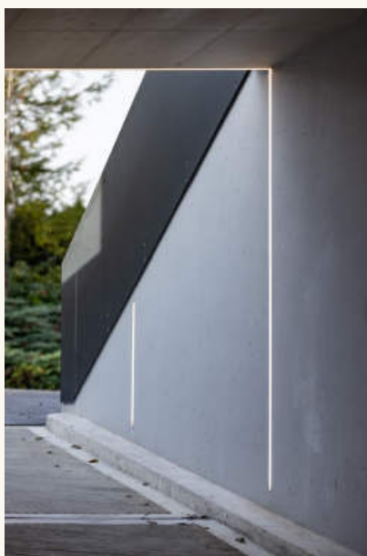
7 Beckenrand und Wendeltreppe: Die Feinsteinzeugplatten laufen über die Beckenwand bis zur Dachkante, der Stahlzylinder der Treppe führt in den Dachgarten. 8 Detail der Einfahrt: Die Lichtlinie läuft über Wand und Decke in einem Zug, die schräge Blechverkleidung folgt der Rampe. Foto: foter.sk
