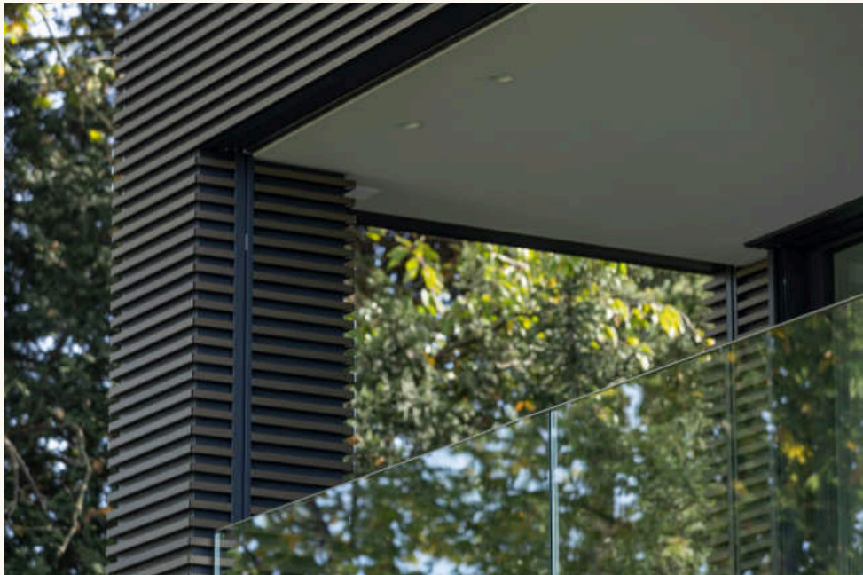
17 Loggia im Obergeschoss: Die Aluminiumprofile laufen um die Ecke in die Leibung, Rafflamellen und Glasbrüstung, die Untersicht als glatte Fläche. Foto: foter.sk
