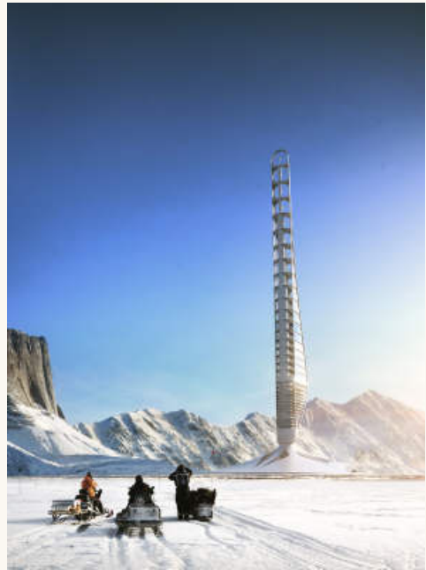
3 Von oben: der Turm als Flügelprofil mit den Turbinenzonen in der Achse, Heliport an der Spitze, die offenen Decks für Forschung und Wohnen dazwischen. 4 Form follows force: der Turm am Rand des Eises, neunzehn Windturbinen im verjüngten Schaft, die Hülle wie eine Haifischhaut. Visualisierung: FlyingArchitecture
