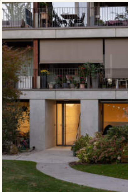
16 Balkonecke: Fertigteilbrüstung, Stahlstütze, Stabgeländer und Fallarmmarkise. 17 Hauseingang von der Gartenseite am Abend: Sichtbetonpfeiler, darüber die Balkonzone mit Bepflanzung. Foto: foter.sk
