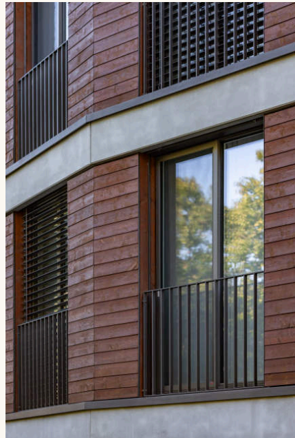
10 Attikageschoss: Holzschalung im Streiflicht, Stahlgeländer, Staffelung der beiden Dachgeschosse.
