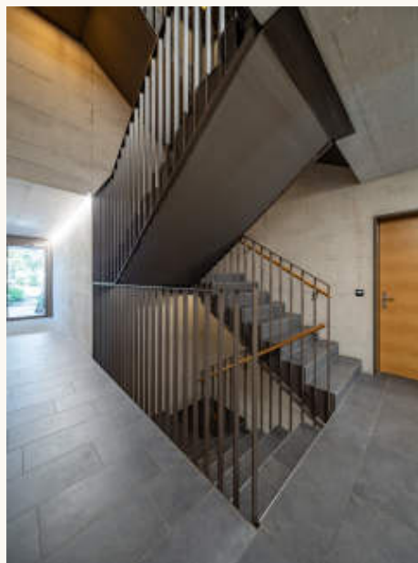
18 Im Quartier: der Baukörper mit den zurückgestaffelten Attikageschossen zwischen den Nachbarbauten. 19 Eingangshalle: Sichtbeton, Stahlterre mit Stabgeländer, Holzhandlauf, Blick in den Garten. Foto: foter.sk
