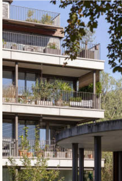
12 Vom Park: die begrünten Balkonschichten über der Spielwiese, dahinter der Baumbestand. 13 Balkonzone und Pavillon: Die Balkone liegen als zweite Schicht vor der Hülle, die Stützen aus Stahl; im Vordergrund das runde Betondach des Sitzplatzes. Foto: foter.sk
