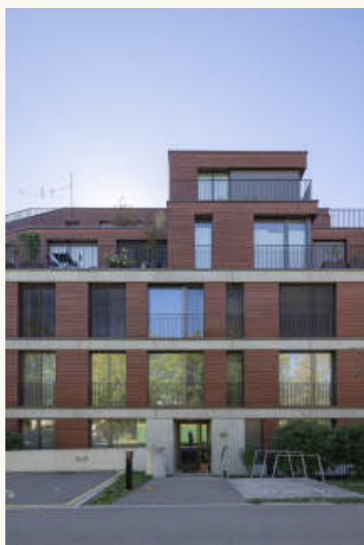
7 Strassenfassade Haus 10a: Lochfassade in horizontaler Holzschalung, Brüstungsbänder in Beton, die beiden zurückgestaffelten Attikageschosse. 8 Strassenseite von der Ecke: Die Attika schliesst mit einer Dachschräge ab, die Geländer als dünne Stabgitter vor der Holzschalung. Foto: foter.sk
