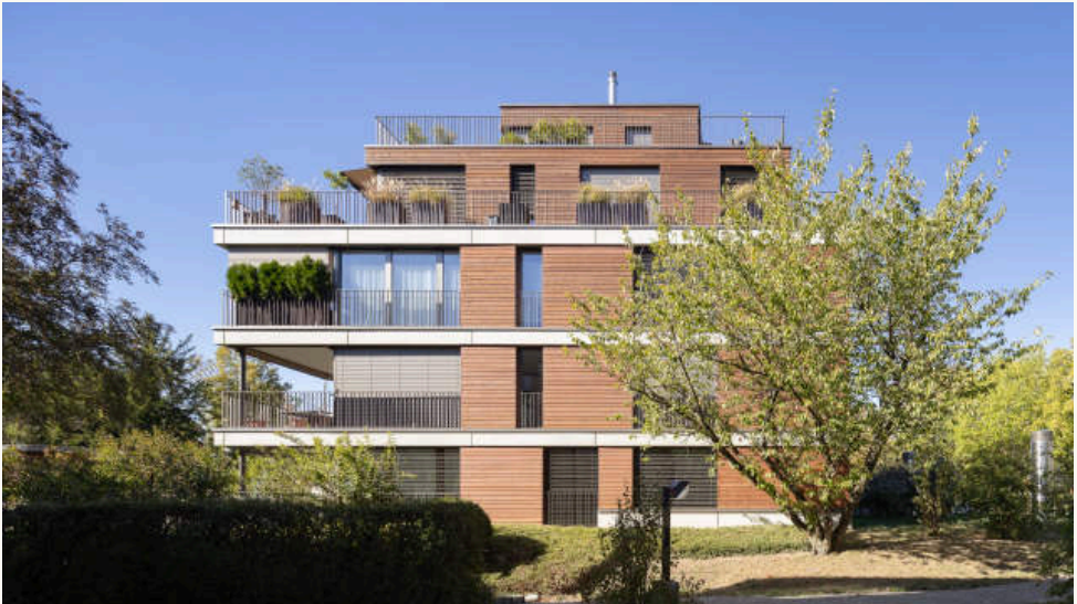
1 Parkseite. Hinter dem Haus bleibt der Baumbestand erhalten; die umlaufende Balkonzone liegt als zweite Schicht vor der thermischen Hülle, die Attikageschosse sind begrünt. Foto: foter.sk
