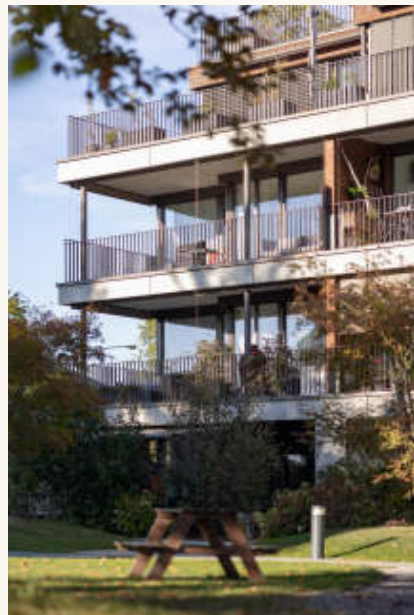
14 Gartenseite: die durchlaufenden Brüstungsbänder und Fallarmmarkisen entlang des geknickten Baukörpers. 15 Balkone zum Park, davor der Picknicktisch auf der Wiese. Foto: foter.sk
