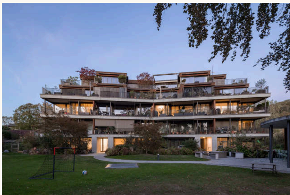
6 Gartenseite am Abend: Die Brüstungsbänder aus Betonfertigteilen laufen um den geknickten Baukörper, dazwischen die umlaufende Balkonzone; davor die Spielwiese des Parks. Foto: foter.sk
