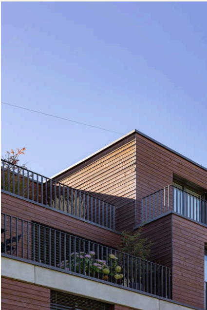
10 Attikageschoss: Holzschalung im Streiflicht, Stahlgeländer, Staffelung der beiden Dachgeschosse.
