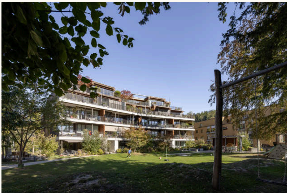
3 Der Park hinter dem Haus: Spielwiese unter dem erhaltenen Baumbestand, die Balkonzone bepflanzt, die Attikageschosse begrünt. Foto: foter.sk
