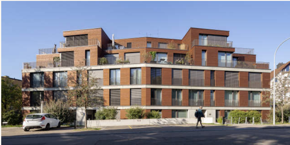
2 Ansicht von der Zürichstrasse: der Baukörper bildet den Abschluss zur Strasse, Brüstungsbänder aus Betonfertigteilen, dazwischen horizontale Holzschalung. Foto: foter.sk
