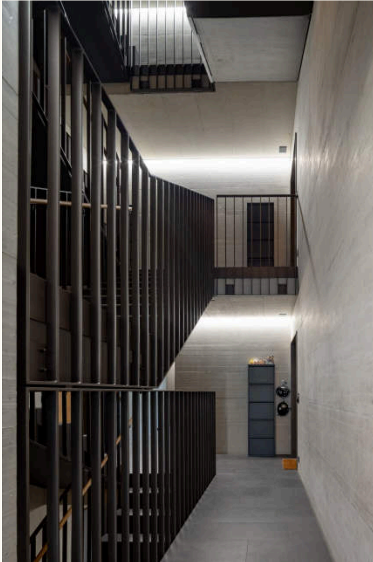
20 Treppenhaus: Stahlgeländer als durchlaufendes Stabgitter, Sichtbeton, Lichtlinie unter der Decke. Foto: foter.sk
