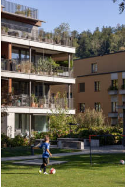
12 Vom Park: die begrünten Balkonschichten über der Spielwiese, dahinter der Baumbestand. 13 Balkonzone und Pavillon: Die Balkone liegen als zweite Schicht vor der Hülle, die Stützen aus Stahl; im Vordergrund das runde Betondach des Sitzplatzes. Foto: foter.sk
