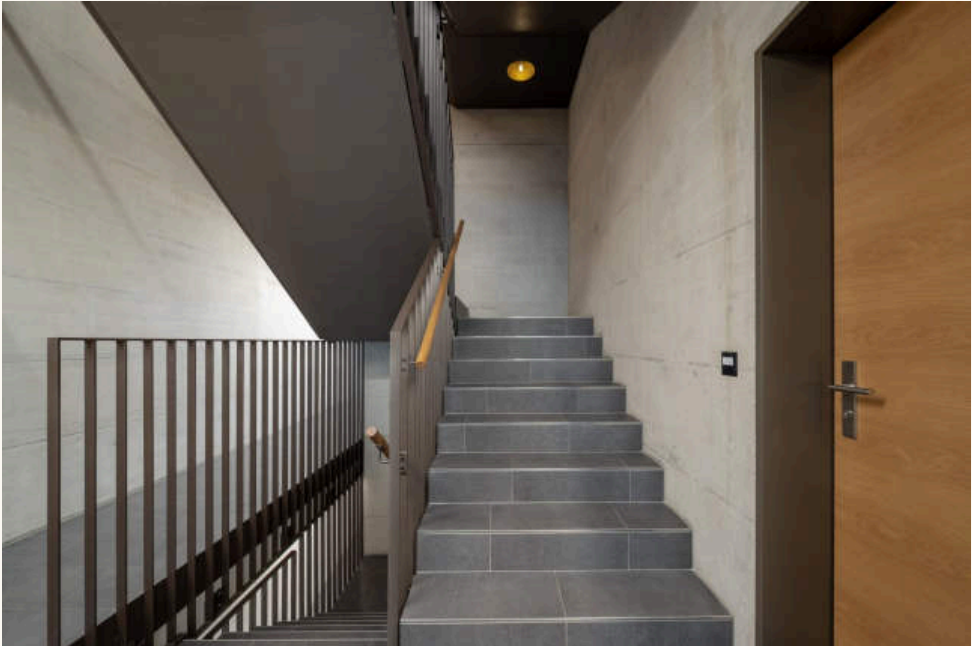
9 Treppenlauf mit Keramikbelag, Stahlgeländer und Handlauf aus Eiche. Foto: foter.sk
