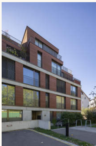
7 Strassenfassade Haus 10a: Lochfassade in horizontaler Holzschalung, Brüstungsbänder in Beton, die beiden zurückgestaffelten Attikageschosse. 8 Strassenseite von der Ecke: Die Attika schliesst mit einer Dachschräge ab, die Geländer als dünne Stabgitter vor der Holzschalung. Foto: foter.sk
