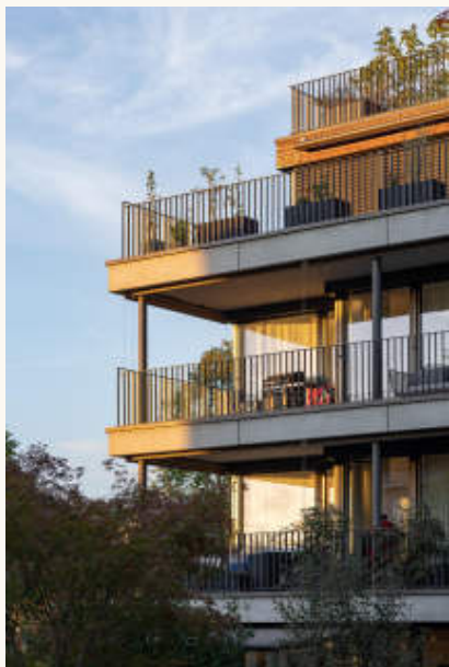
4 Balkonzone im Abendlicht: Betonbänder, Stahlstützen und Staketengeländer vor den raumhohen Verglasungen; Senkrechtmarkisen als Sonnenschutz. 5 Treppenhaus: Geländer aus Flachstahl mit Handlauf in Eiche vor Sichtbeton, die Verbindungen sichtbar verschraubt. Foto: foter.sk
