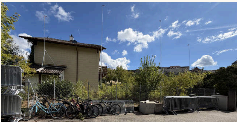
1 Die Parzelle an der Turnhallestrasse, September 2026: das Einfamilienhaus mit Schopf vor dem Rückbau, die Bauprofile des Neubaus gesteckt; im Hintergrund die Festung Aarburg. Foto: Ivanov + Partners
