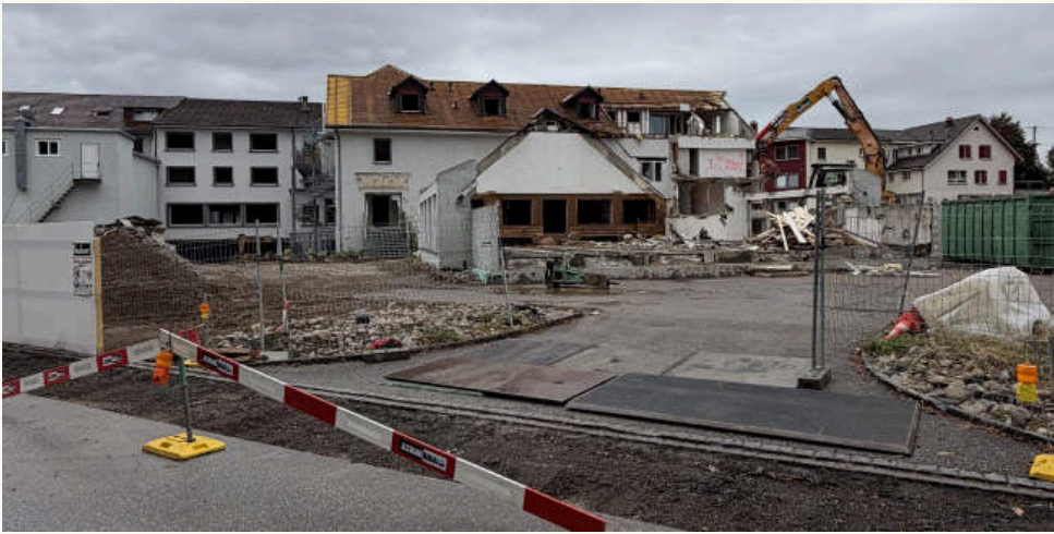
1 Abbruch des Hotels Krone, September 2026: Die Parzelle zwischen Bahnhofstrasse und Strickereistrasse wird frei für die drei Baukörper. Foto: Ivanov + Partners
